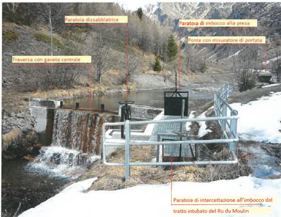
Vista da valle del complesso dell'opera di presa con indicazione delle sue diverse componenti
