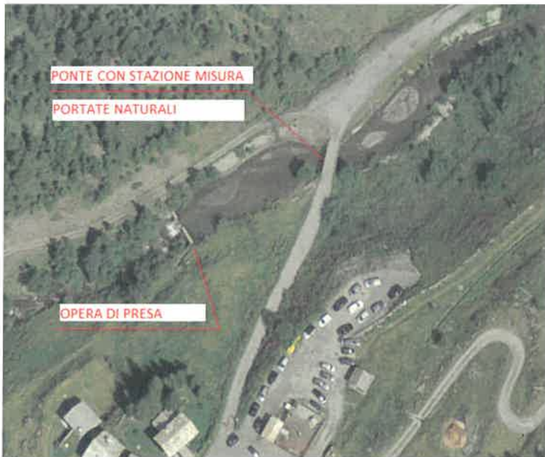
Vista aerea della zona dell'opera di presa del Ru du Moulin
