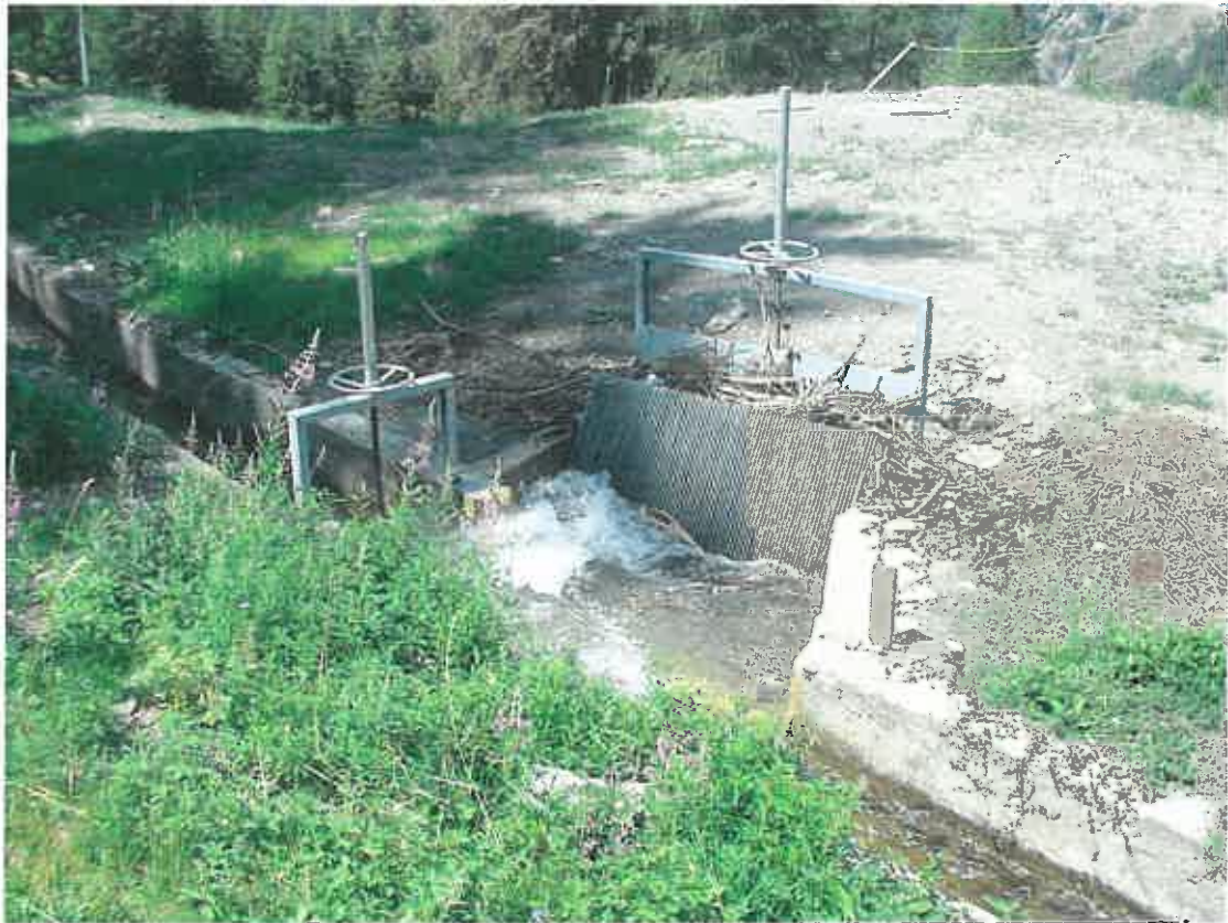
La stessa presa fotografata con una diversa angolazione, che permette di vedere la zona in cui si trova la vasca di carico interrata (accessibile mediante due botole)
