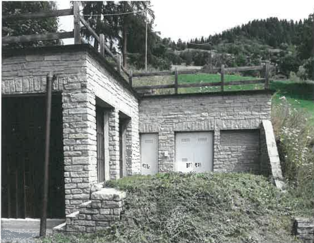
Vista frontale della cabina di consegna a DEVAL e, sulla sinistra, di parte della nuova centrale
