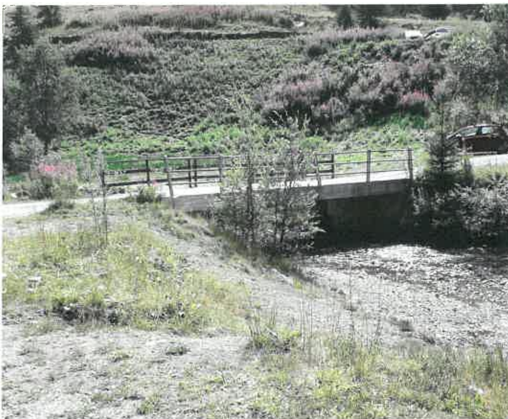
Vista da valle, dalla sponda destra orografica, dello stesso ponte
