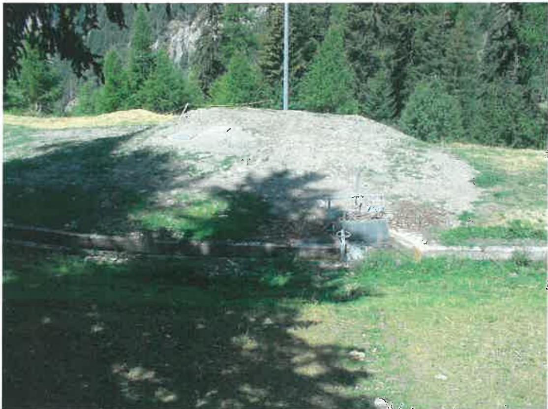
Vista complessiva della presa e della vasca interrata con le botole di accesso L'immagine è stata scattata a lavori da poco ultimati, circa 15 anni fa. Attualmente la superficie è completamente inerbita
