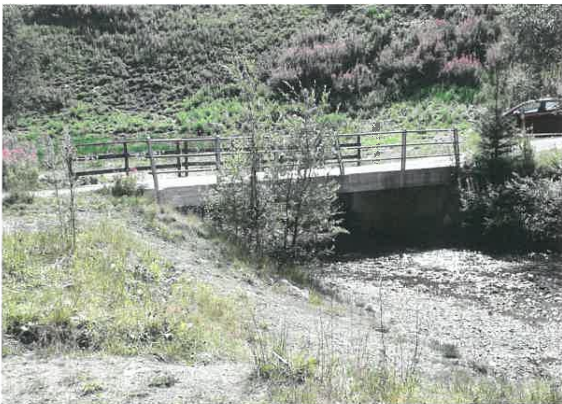
Vista da valle del ponte in corrispondenza del quale verranno misurate le portate naturali del torrente
