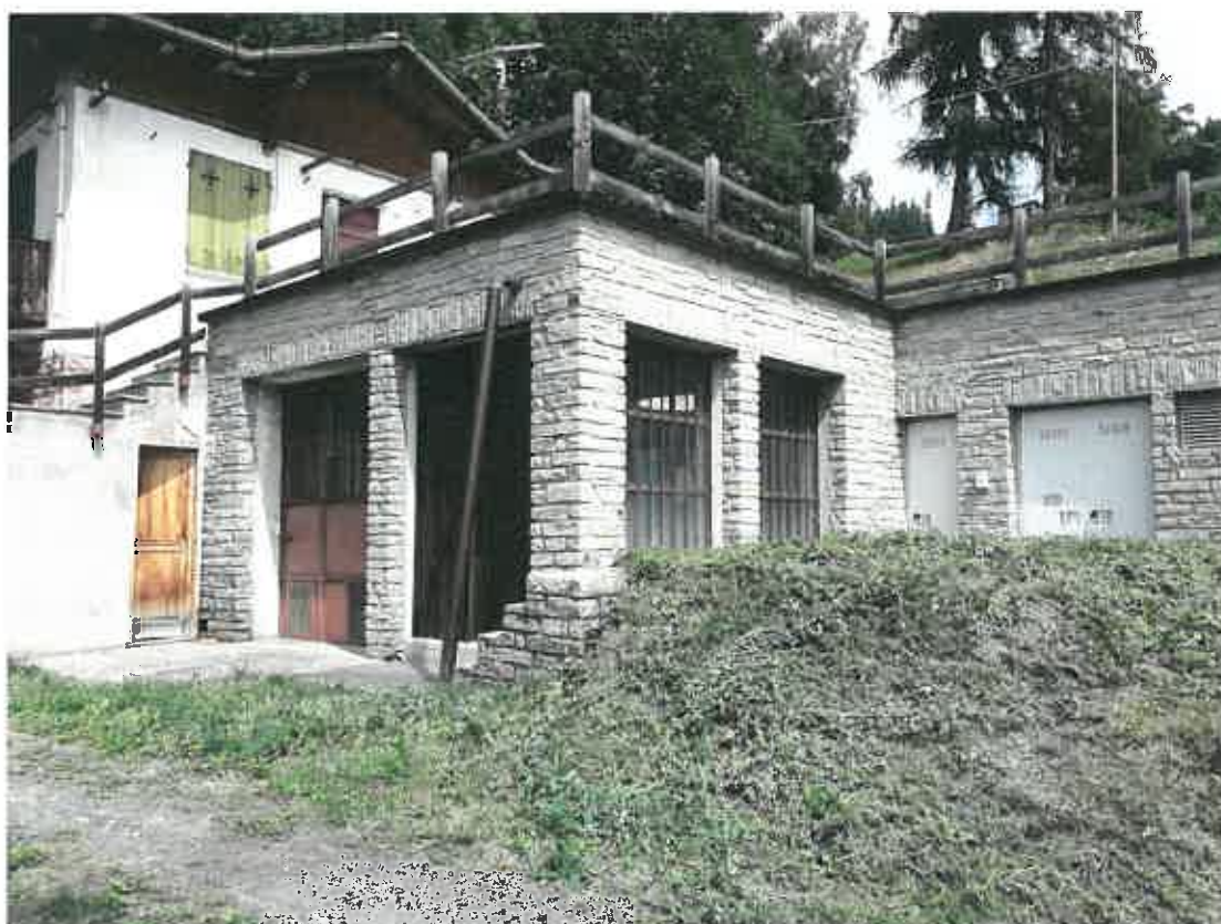
Primo piano del fabbricato della centrale. Più indietro l'edificio, attualmente inutilizzato, che ospitava la vecchia centrale al piao terra e l'alloggio per il custode al primo. Sulla destra si intravede la cabina di consegna a DEVAL
