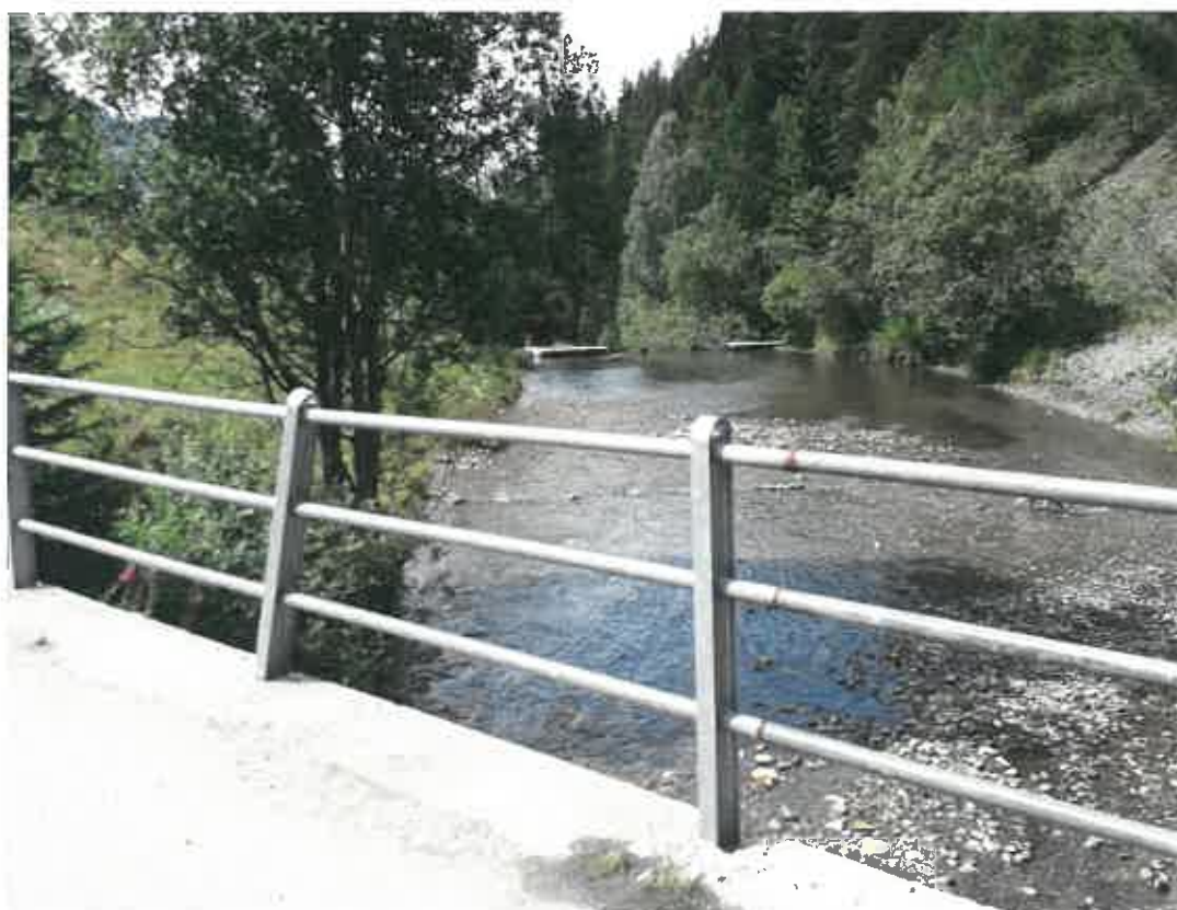
Vista da monte della traversa dell'opera di presa sul torrente Grand Eau L'immagine è stata scattata dal ponte in corrispondenza del quale vengono misurate le portate naturali del torrente
