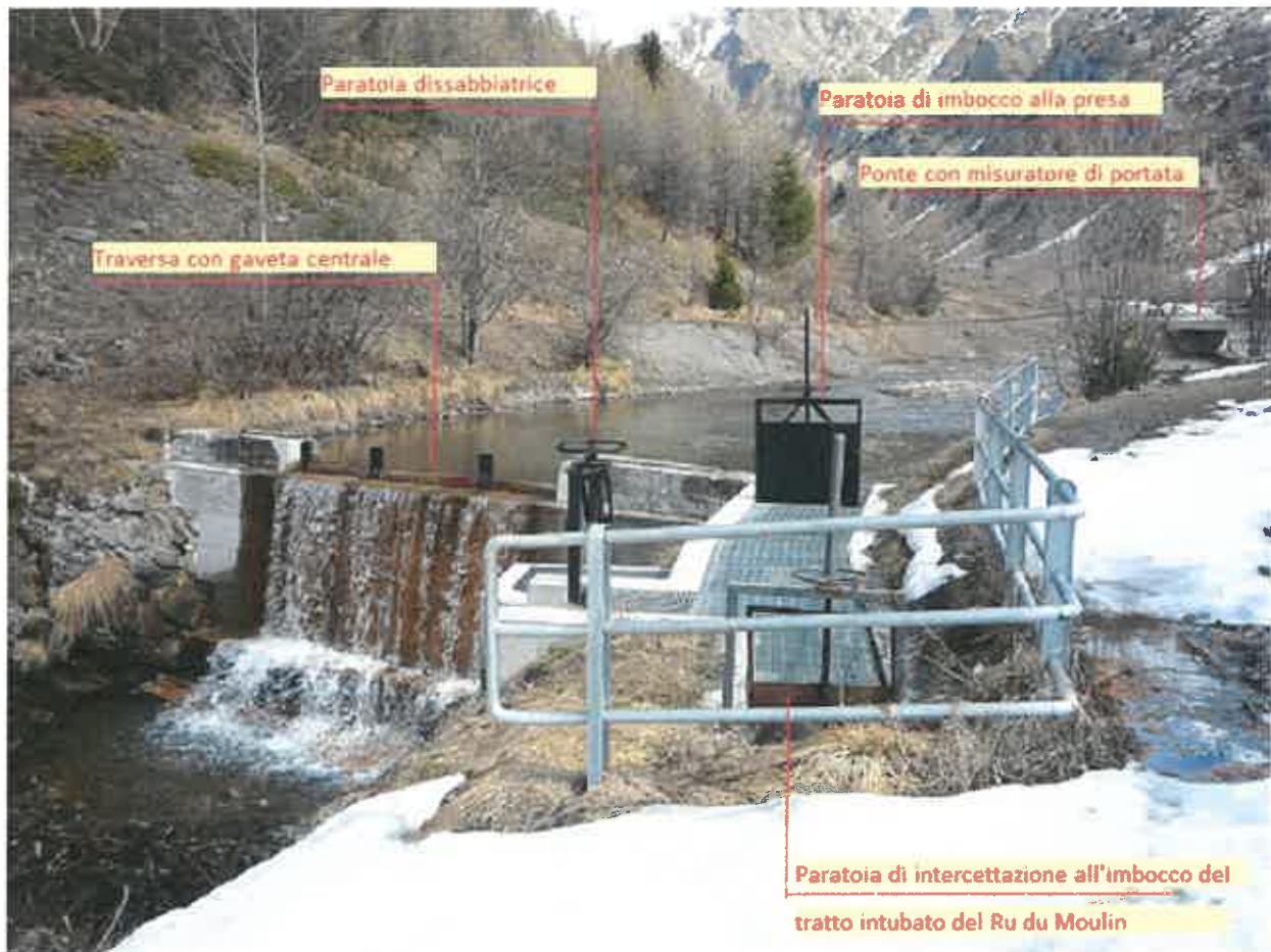
Vista da valle dei manufatti di presa del Ru du Moulin, sullo sfondo il ponte
